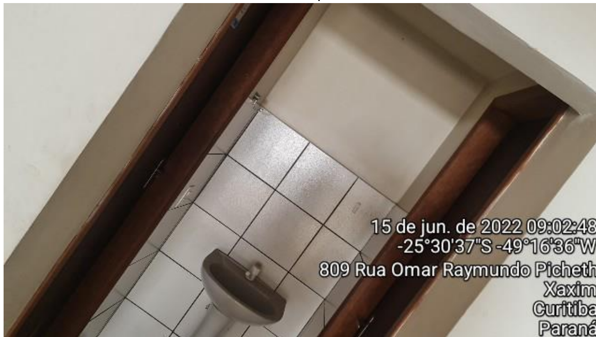
Banheiros - 1º pavimento
