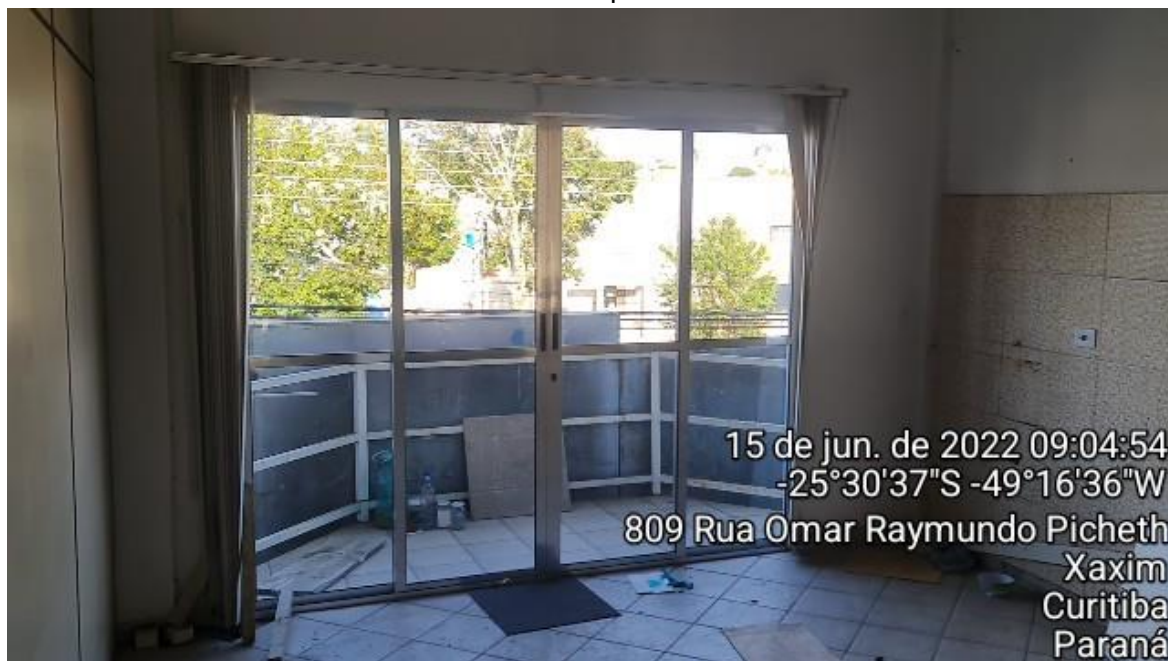
Varanda - 2º pavimento
