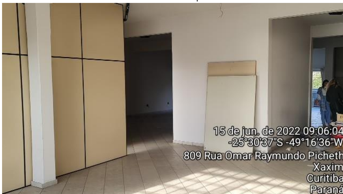
Interior do imóvel - 2º pavimento
