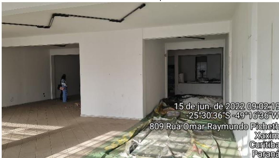
Interior do imóvel - 1º pavimento
