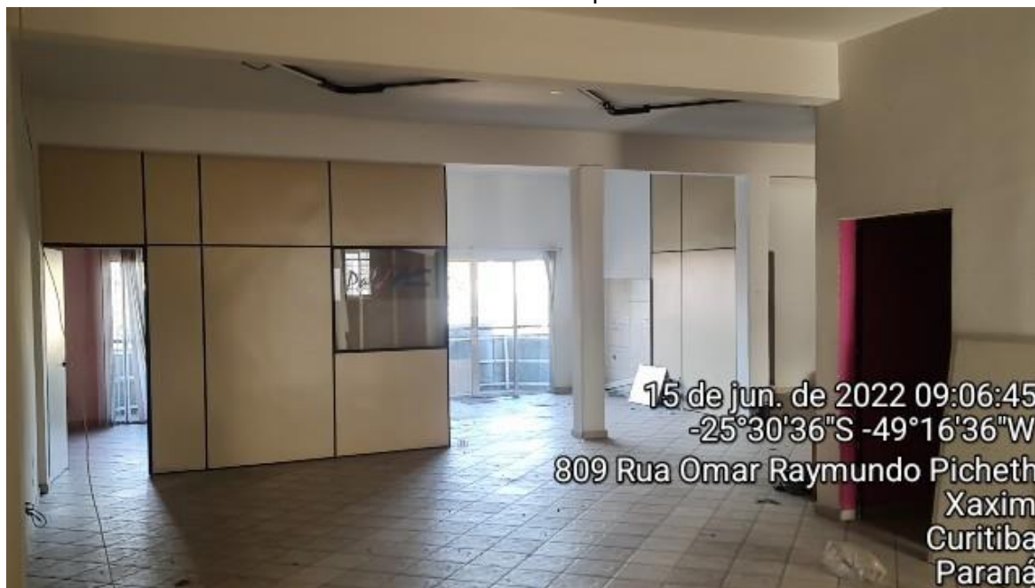
Interior do imóvel - 2º pavimento
