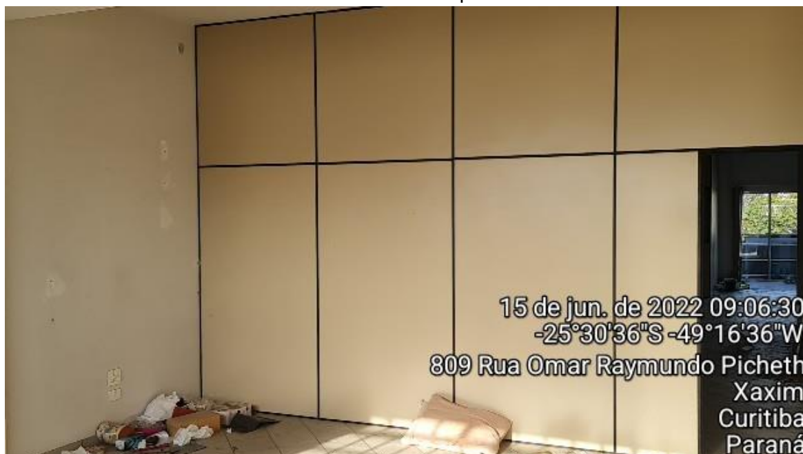
Interior do imóvel - 2º pavimento
