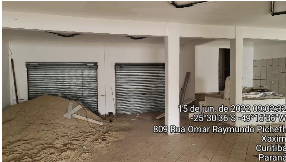
Interior do imóvel - 1º pavimento
