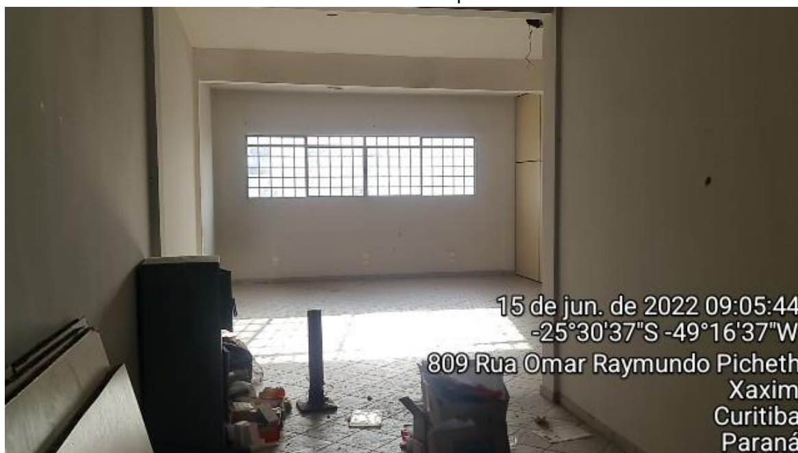
Interior do imóvel - 2º pavimento
