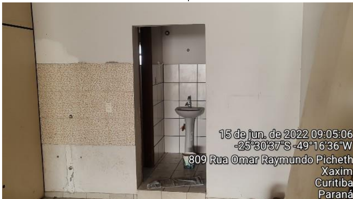
Banheiros - 2º pavimento
