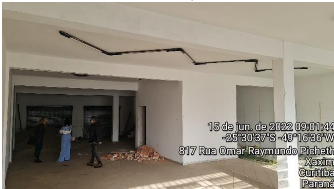
Interior do imóvel - 1º pavimento
