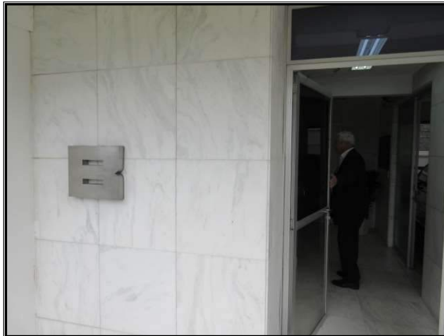
Foto nº 05 – Vista da identificação do bloco predial do imóvel.
