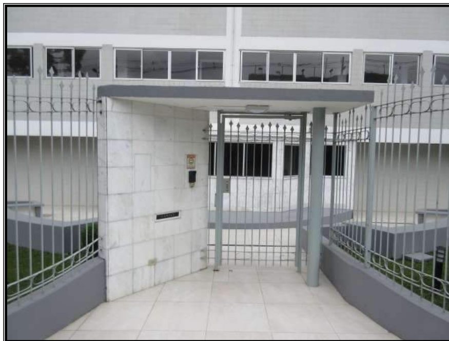
Foto nº 03 – Vista da fachada do imóvel.
