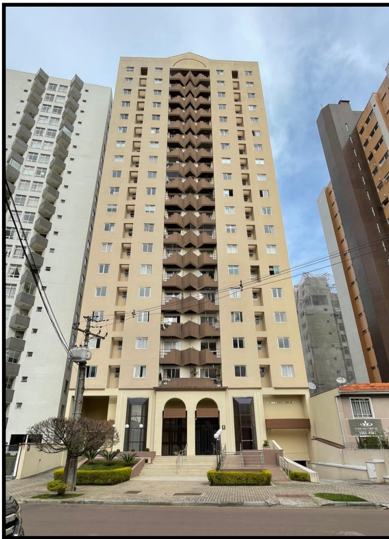
Figura 2 – Vista da fachada frontal do Edifício Menotti Del Picchia.
